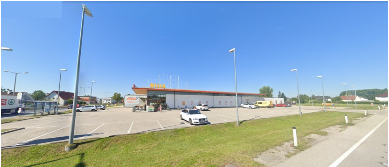
Blickrichtung Westen: Straßenfront von der Werfelstraße gesehen (Ein- und Ausfahrt rechts im Bild)
