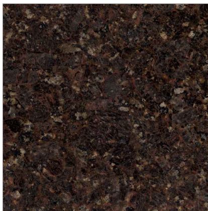
Fassade Bestand Granit
