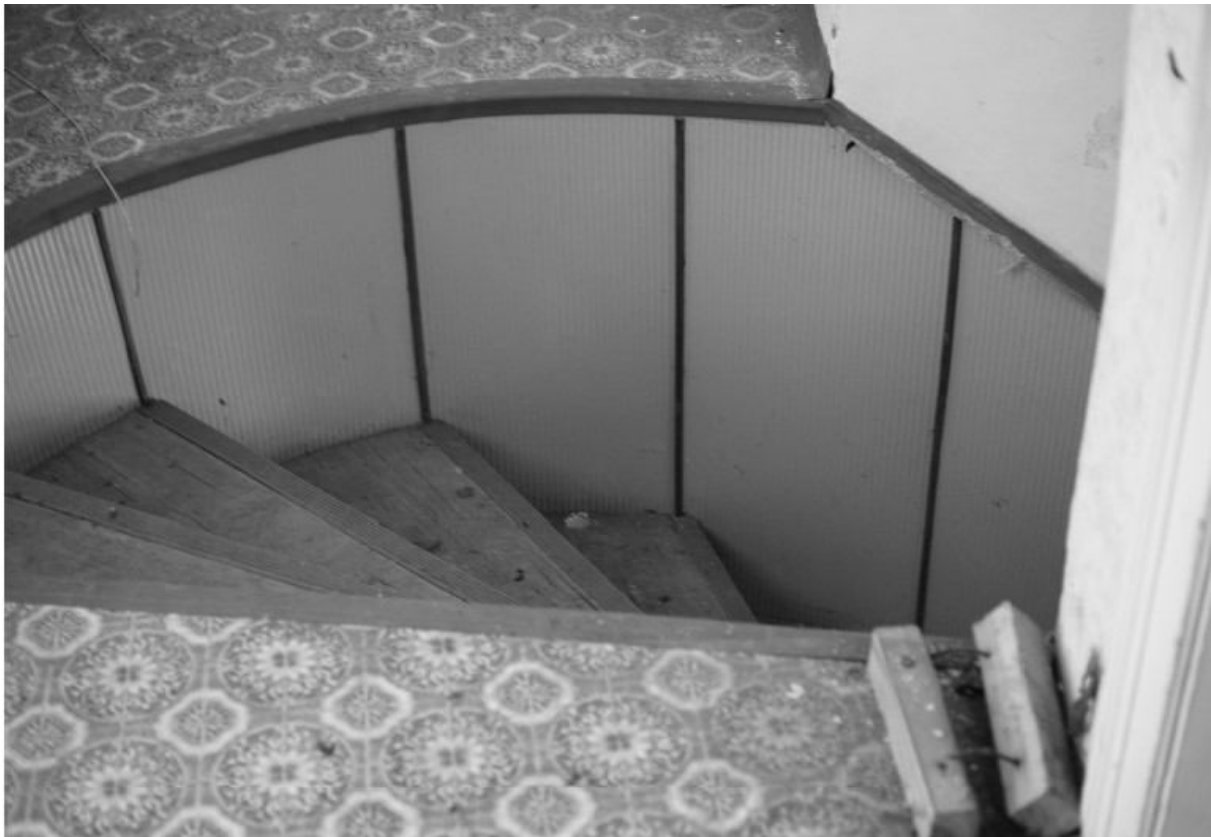
Abbildung 4 – Haus Böhmngasse 3 , bestehende Stiege
