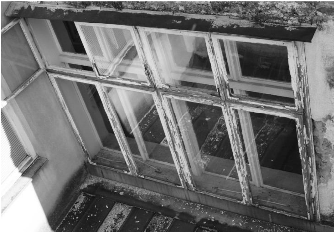
Abbildung 6 – Haus Böhmigasse 3 , bestehendes Kastenfenster in den Innenhof
