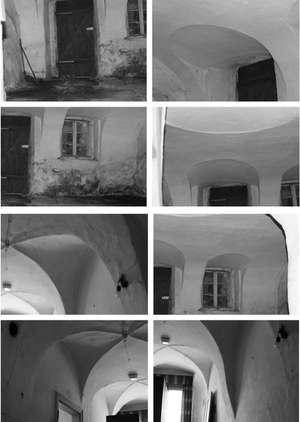
Abbildung 2 – Haus Böhmstraße 3 , Kreuzgewölbe
