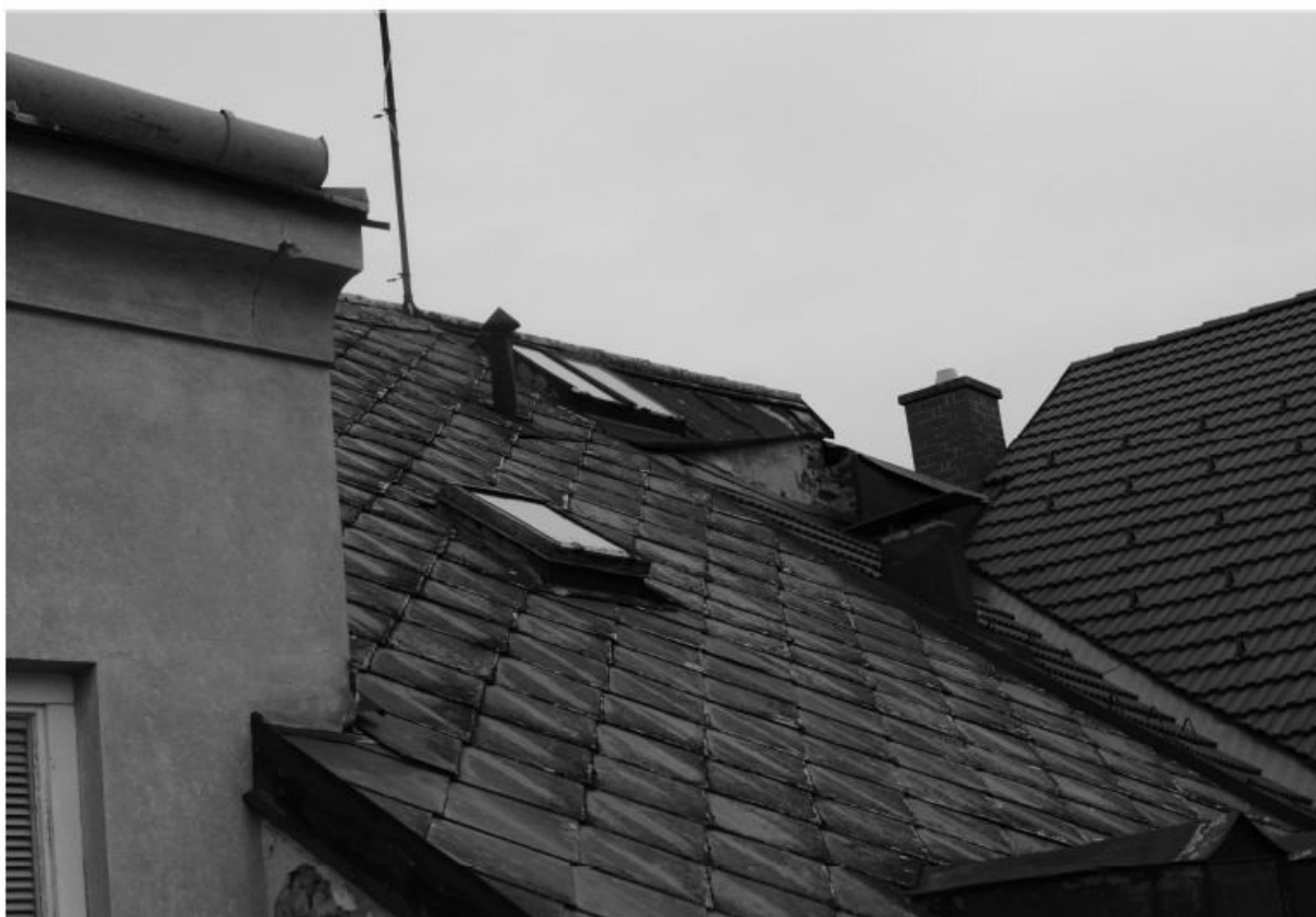
Abbildung 7 – Haus Böhmstraße 3 , Dachaufbauten Richtung Innenhof
