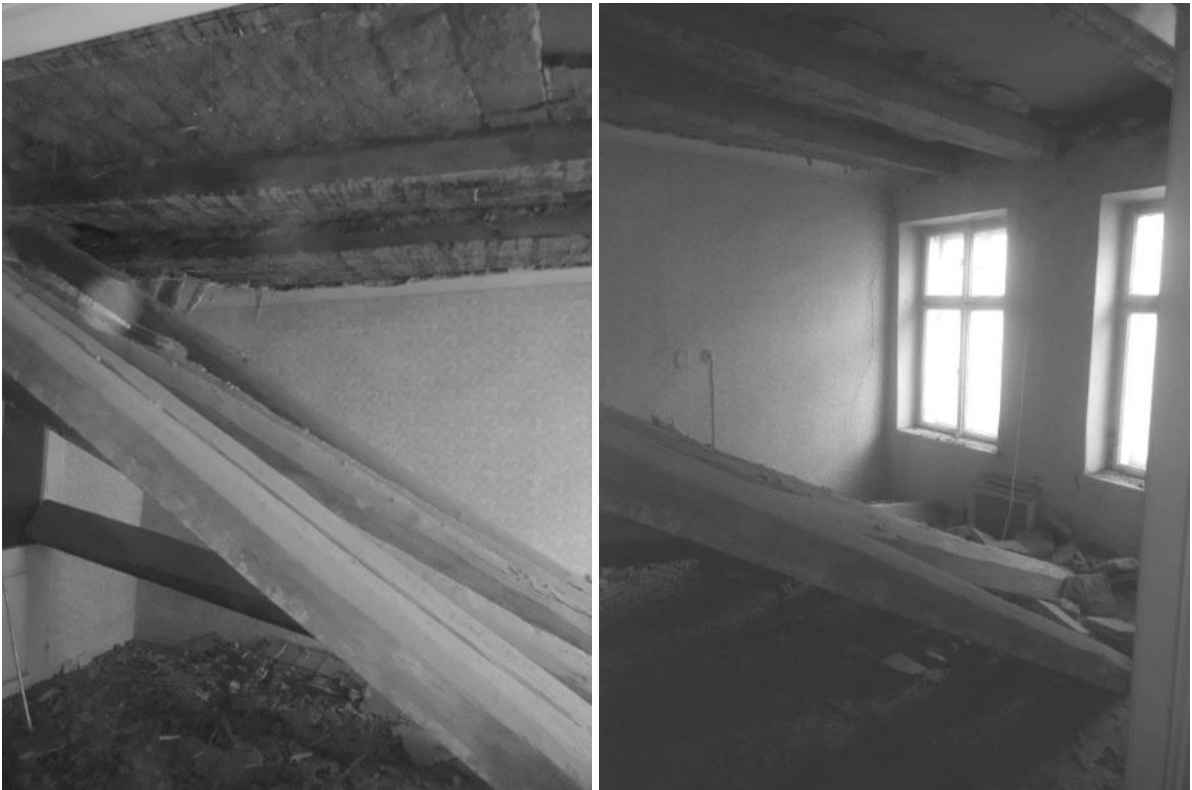
Abbildung 5 – Haus Böhmigasse 3 , eingebrochene Deckenbalken Zimmer 1
